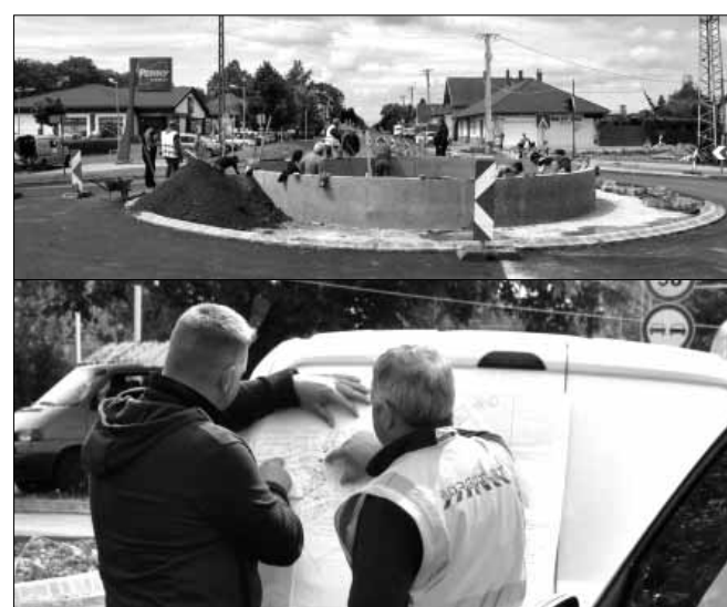
Látványosan épül a körforgalmi csomópont, a közúti forgalom nincs elterelve, forgalomirányító lámpákkal, táblákkal irányítva szinte folyamatos
