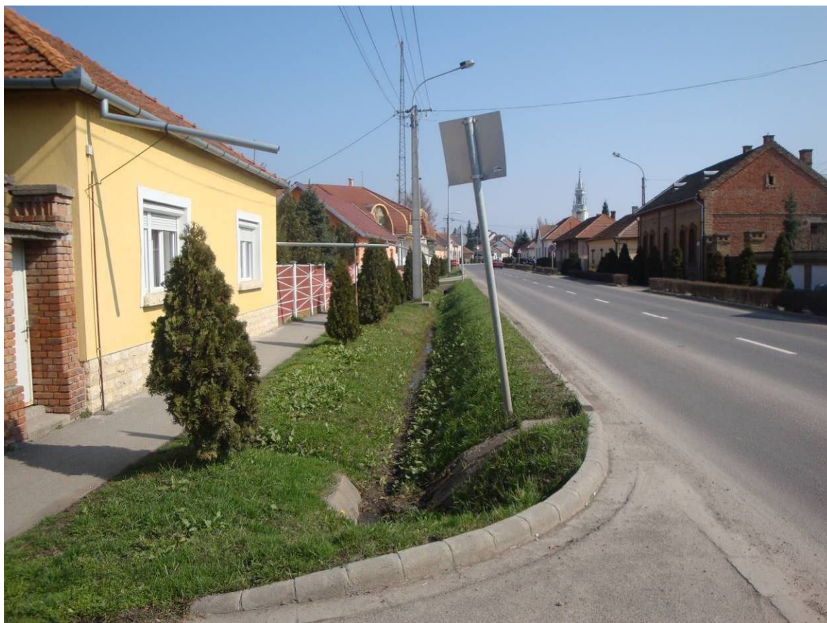
Csapadékvíz-elvezető árok a Kossuth Lajos utcán
