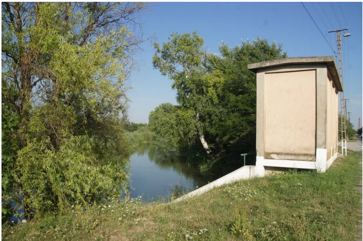
A Kopolya-csatorna és a Bárkás-csatorna torkolata a vízkormányzó műtárggyal
