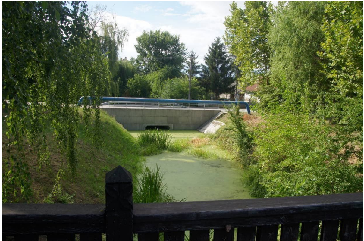
A Gyepes-főcsatorna Vár utca alatti hídjá
