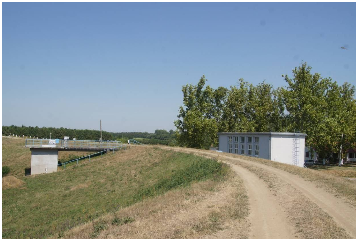
A Malomfoki szivattyútelep a belvízvédekezés egyik fontos műtárgya
