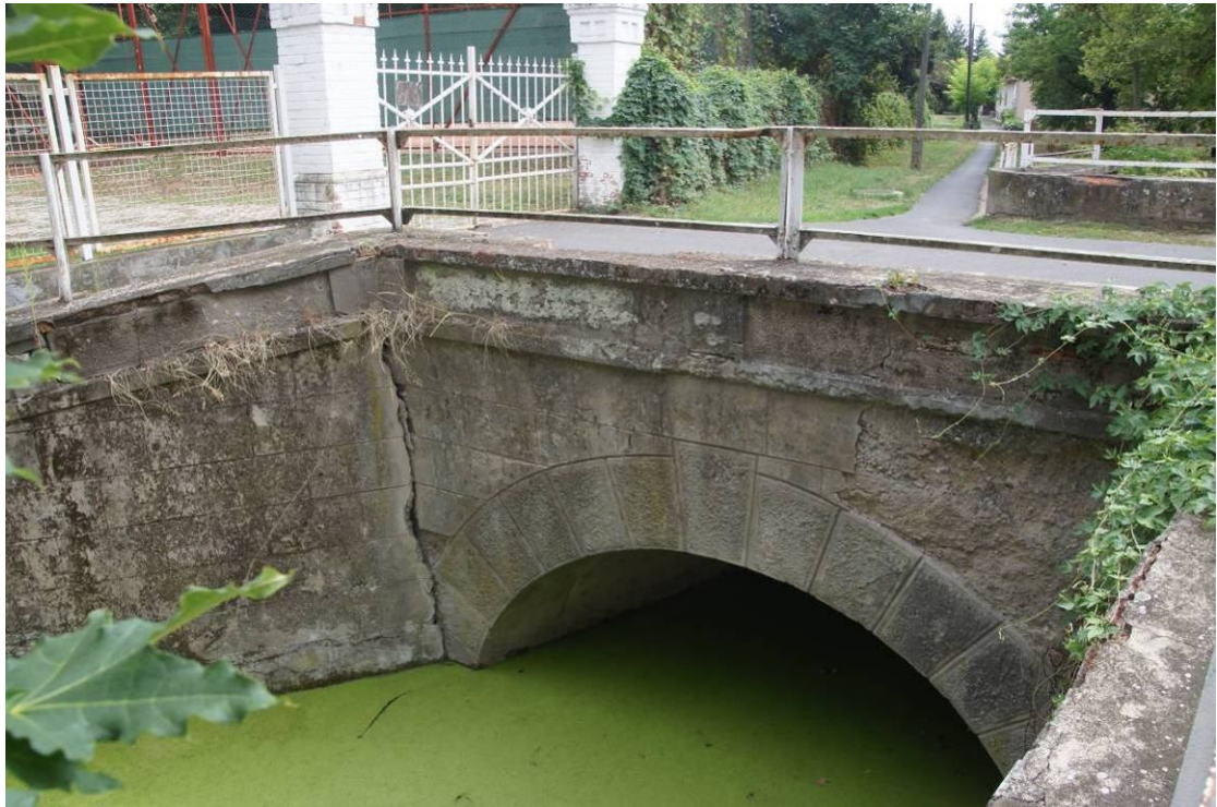
A Gyepes-főcsatorna hídjá a gimnázium és a kollégium mögött
