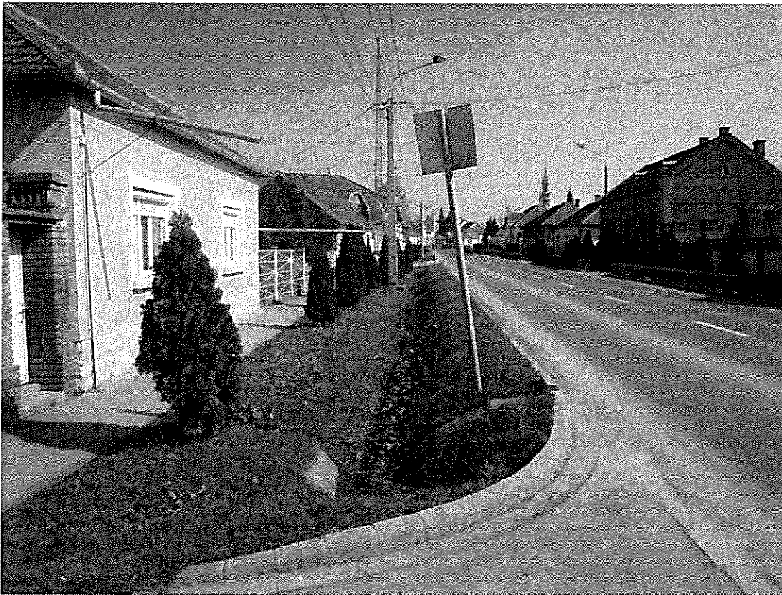
Csapadékvíz-elvezető árok a Kossuth Lajos utcán
